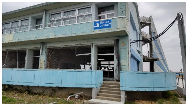
震災遺構 浪江町立請戸小学校
